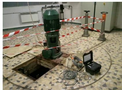
Réalisation d'une vérification thermographique des installations électriques.
